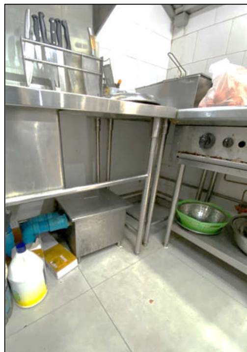
ภาพที่ 36 แสดงบ่อดักไขมันภายในห้องครัว
