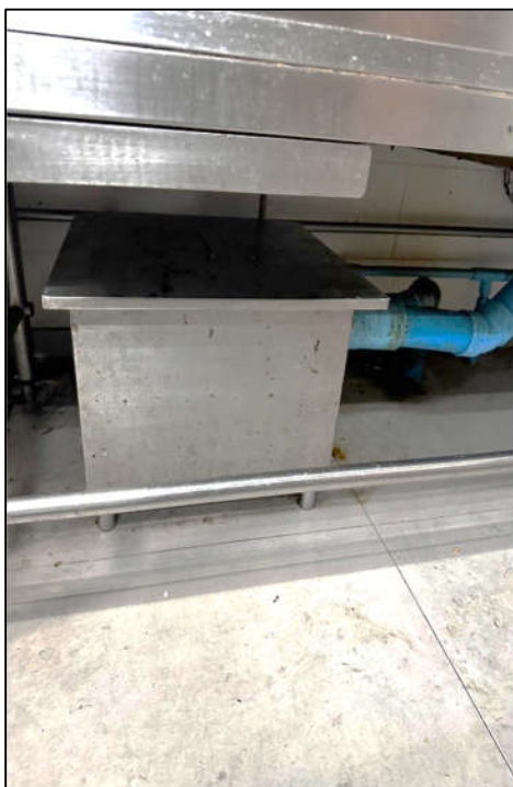
ภาพที่ 36 แสดงบ่อดักไขมันภายในห้องครัว
