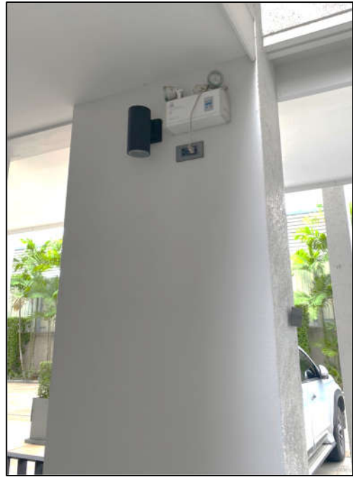
ภาพที่ 25 แสดงไฟส่องสว่างฉุกเฉิน
