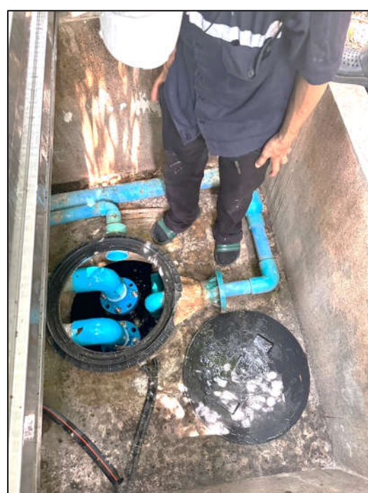
ภาพที่ 44 แสดงถังเก็บน้ำสำรองใต้ดิน
